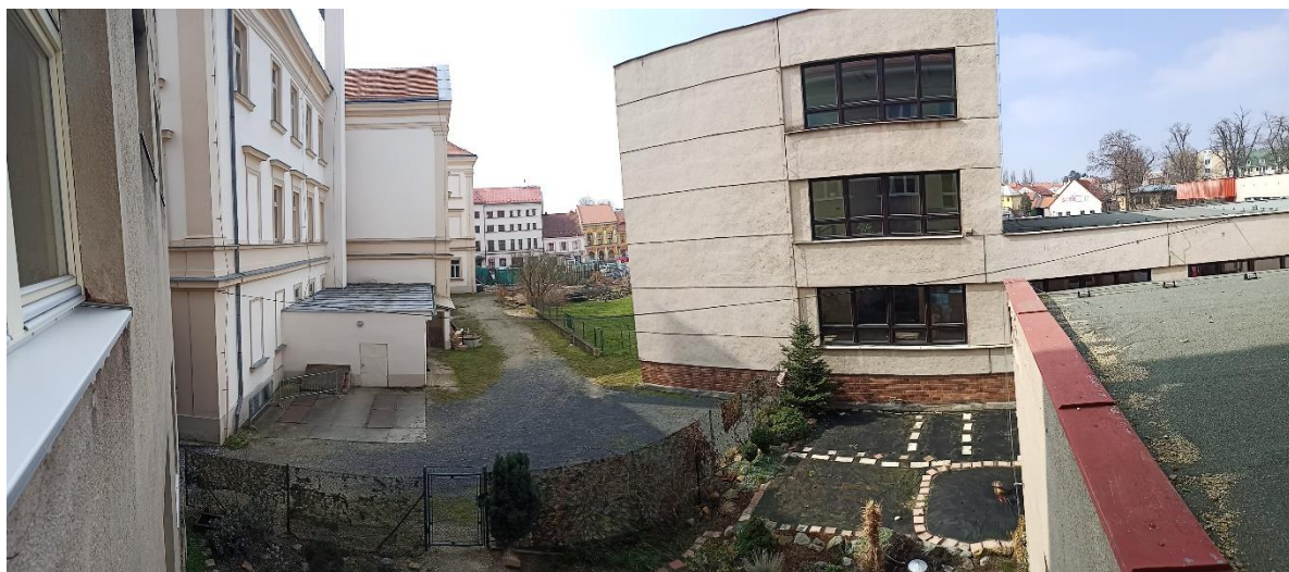
dvůr – panorama (vlevo stará budova, vpředu nová budova)
