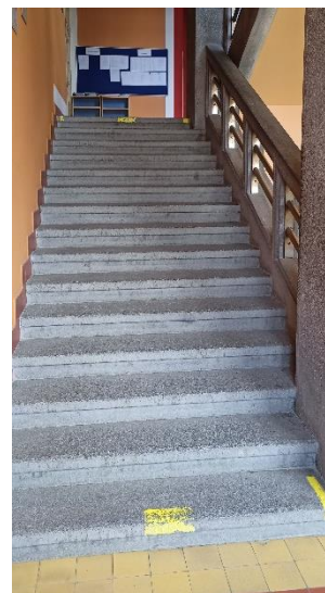
stará budova - schodiště z odpočívadla do 1. patra
